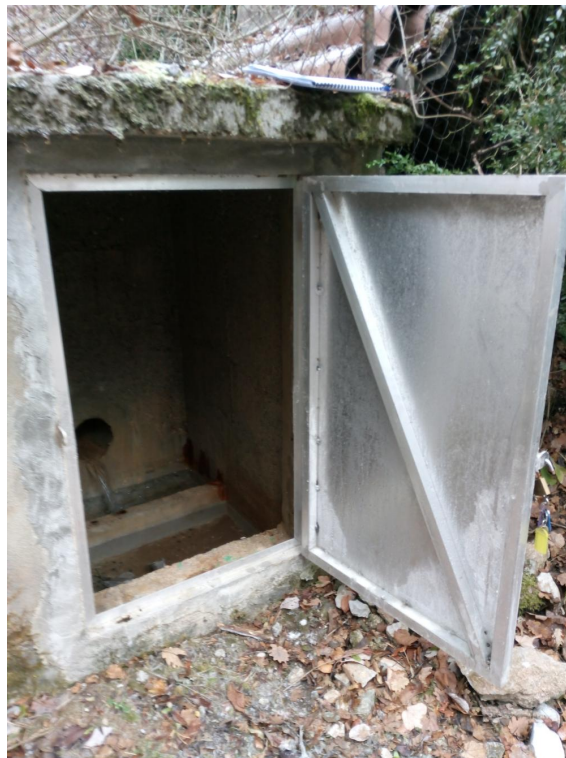
FIGURE 7 – Source de la Rate, captage amont : vue de la chambre de captage
