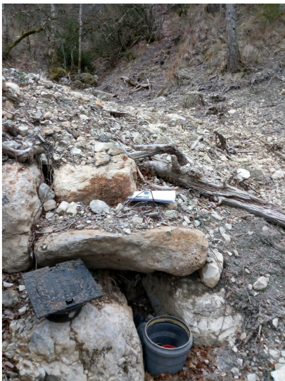
FIGURE 10 – Source de la Rate : regard de captage aval
