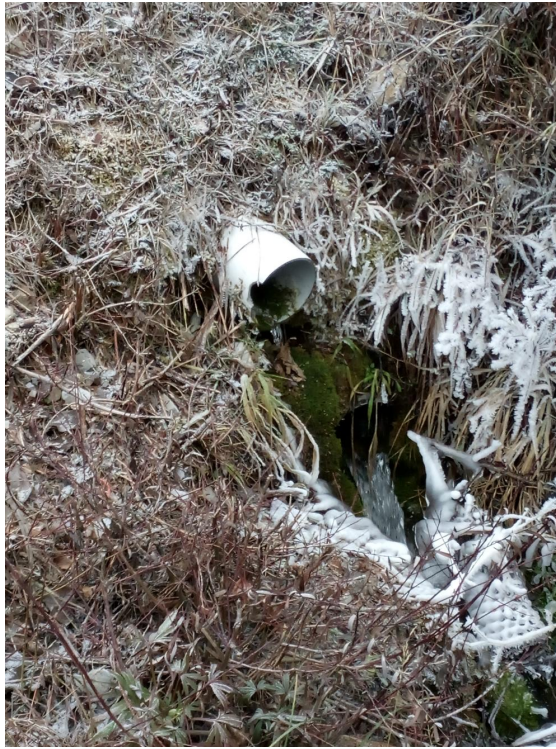
FIGURE 20 – font de Saule : drains de surverse (PVC blanc) et écoulement issu du drain Ouest non capté.
