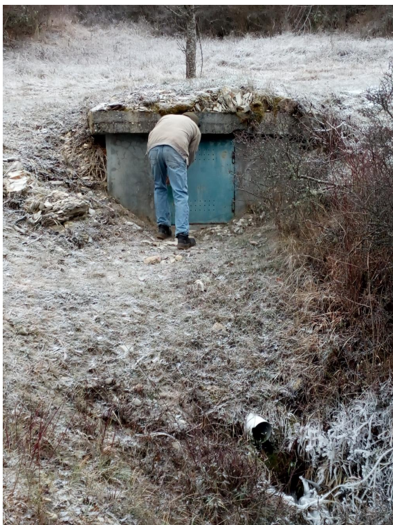
FIGURE 17 – font de Saule : chambre de captage, évacuation du trop-plein (drain PVC blanc), écoulement issu du drain Ouest non capté.
