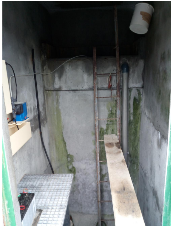
FIGURE 22 – font de Saule : vue intérieure du réservoir.
