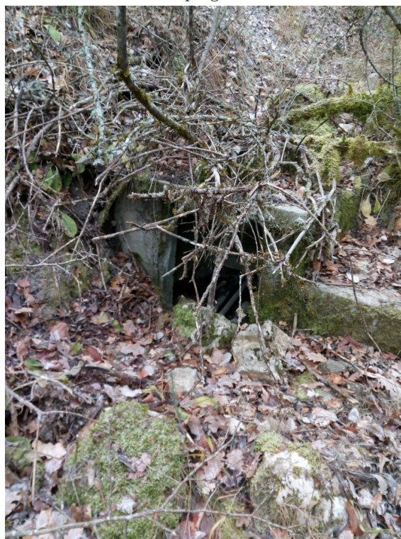
FIGURE 9 – Source de la Rate : boisseau béton entre captage amont et captage aval. Deux conduites et un écoulement à surface libre y sont visibles.
