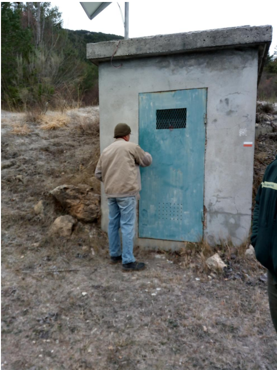
FIGURE 21 – font de Saule : vue extérieure du réservoir.
