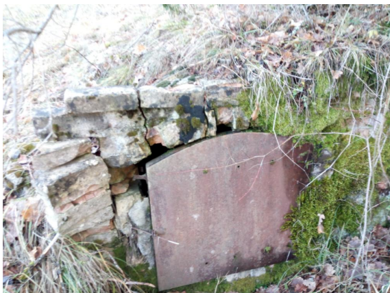
FIGURE 14 – Chambre semi-enterrée située en amont de la chambre de réunion : vue extérieure.
